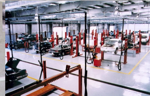
Recubrimiento de gran espesor, con cargas cerámicas y libre de solventes, Floor Tech HB, aplicado en el piso de un taller mecánico.
